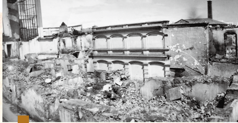
Panorámica del Palacio Arzobispal después del incendio del 9 de abril de 1948 - Colección Henao Sáenz-Archivo Histórico Arzobispal.
